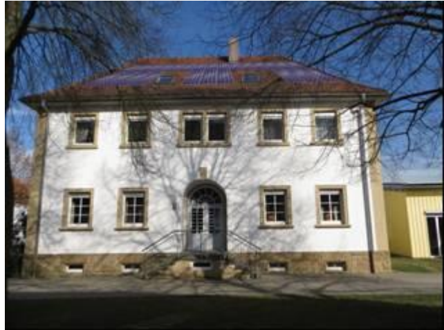
PV Anlage auf West/Südwestdach
