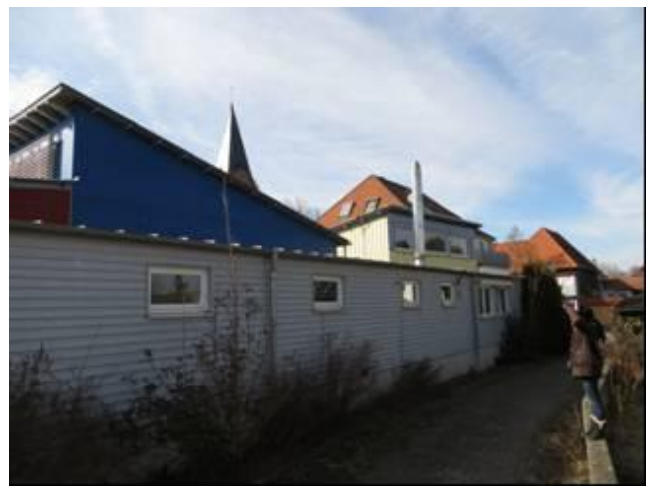
Heizzentrale im EG
